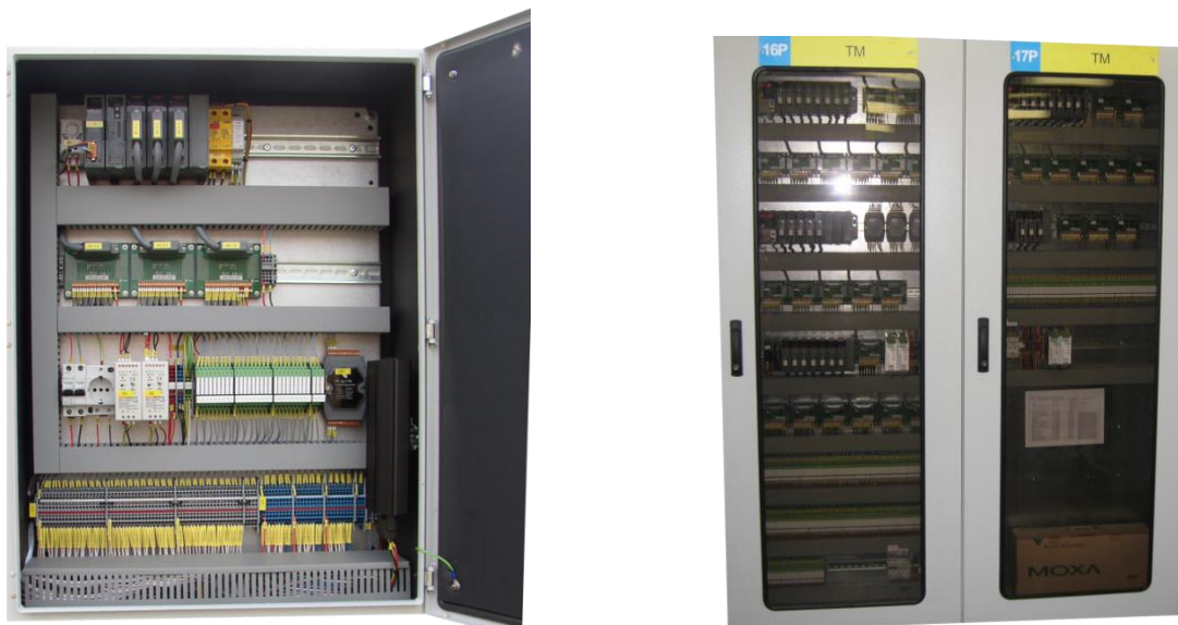
Рис. 1.2 Шкаф навесного (слева) и напольного (справа) исполнения
